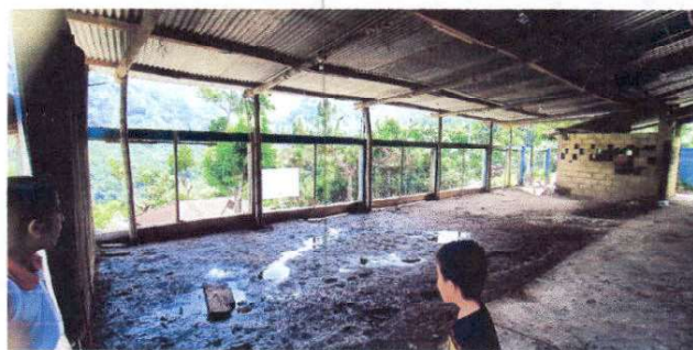
Foto 4: Reparación de piso de torta de concreto.
