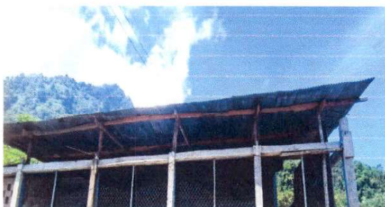
Foto 5: Sustitución de canal
