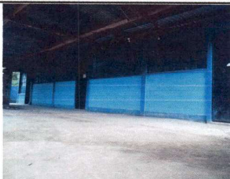
Foto 1: Sustitución de lámina, por lámina troquelada aluzinc calibre 26 de aulas, Sustitución de capote de lámina para lámina troquelada
